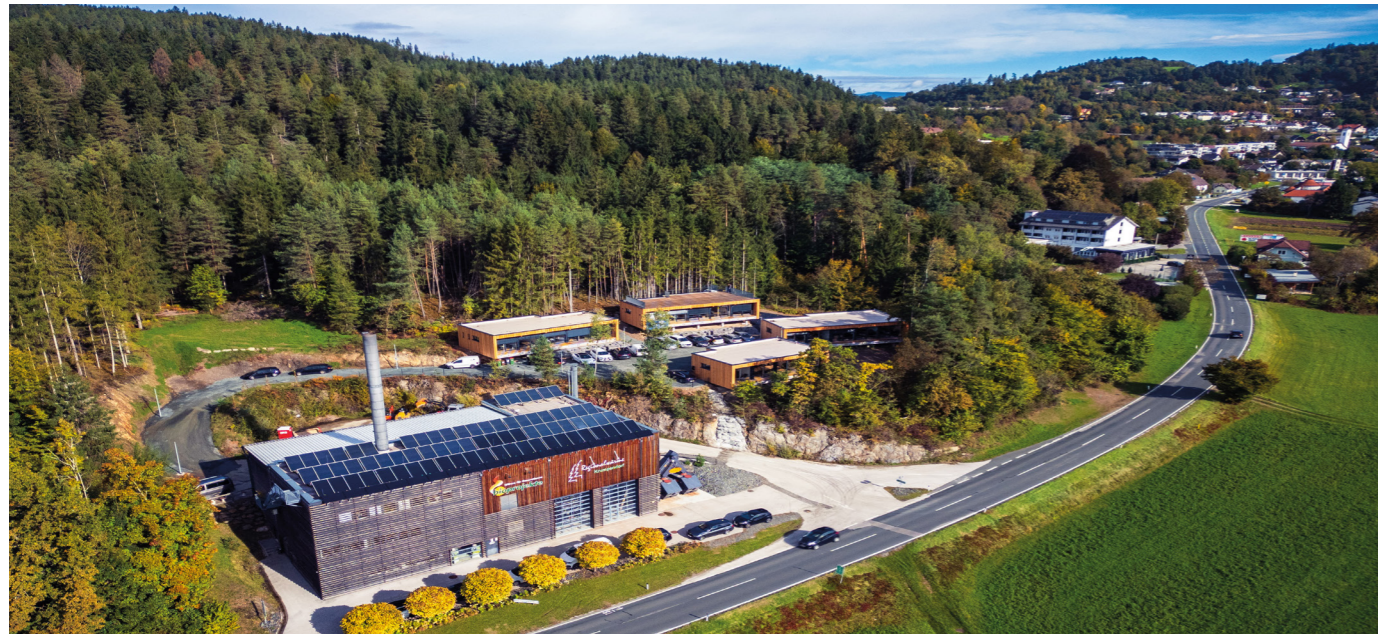
Unsere neuen Bürohäuser oberhalb des Biomasseheizwerks in Krumpendorf
